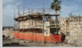
Der südliche Torturm des frühislamischen Kalifenpalastes von Khirbat al-Minya (Israel) während der Restaurierung durch das Institut für Altertumswissenschaften und die Israel Nature and Parks Authority.
